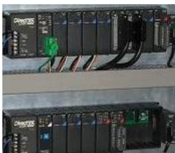
Контроллер DL 205 с доп. каркасом
