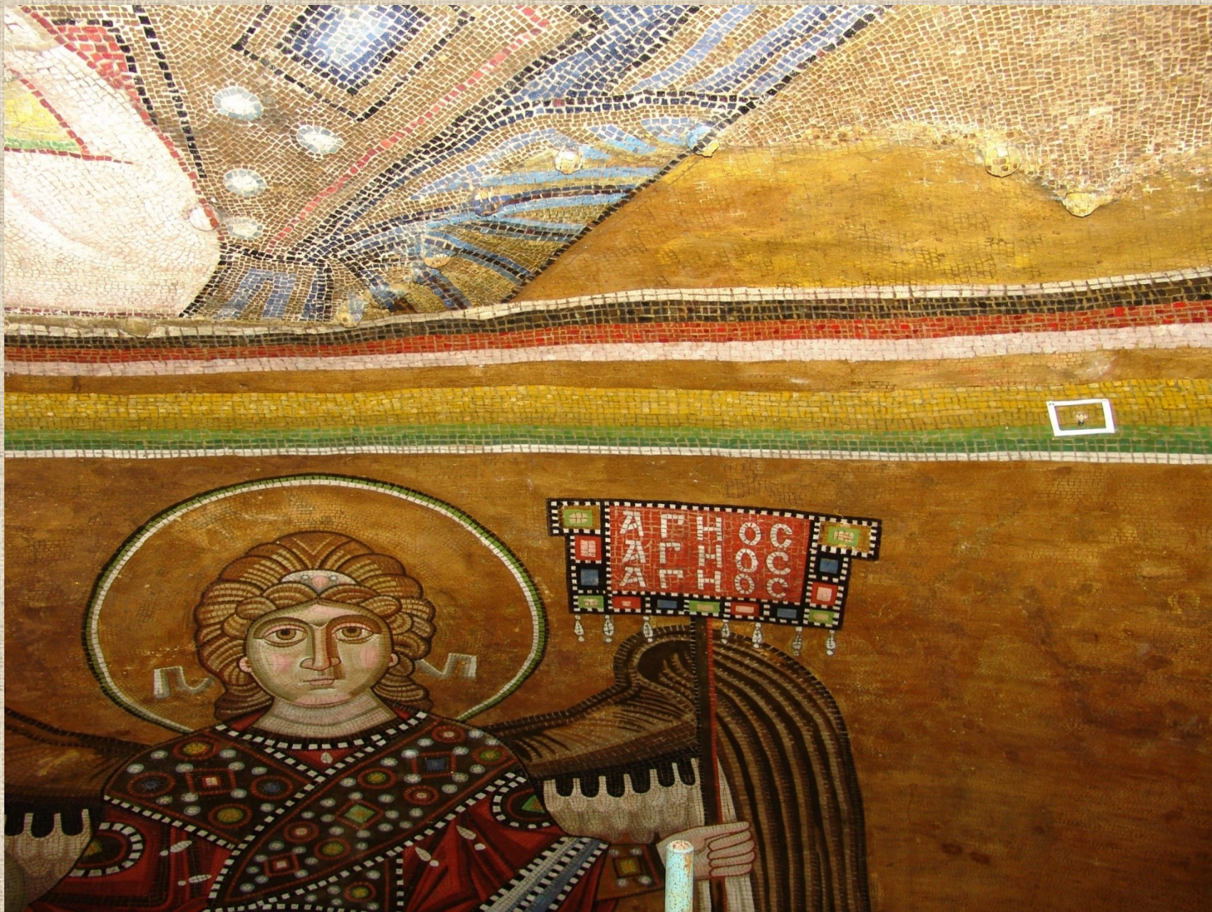
Датчик температуры и влажности в центральном куполе
